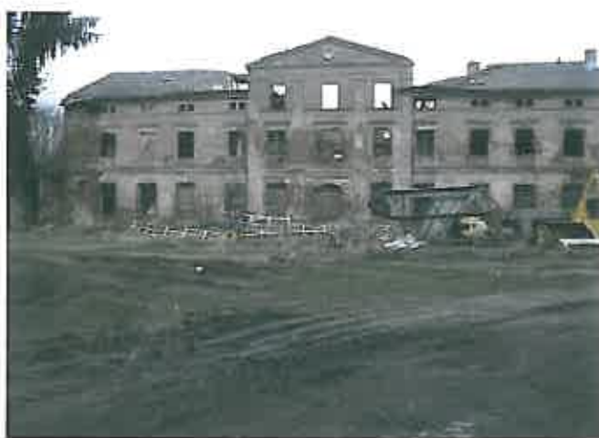
Fot.3. pałac w Karścinie, stan obecny
